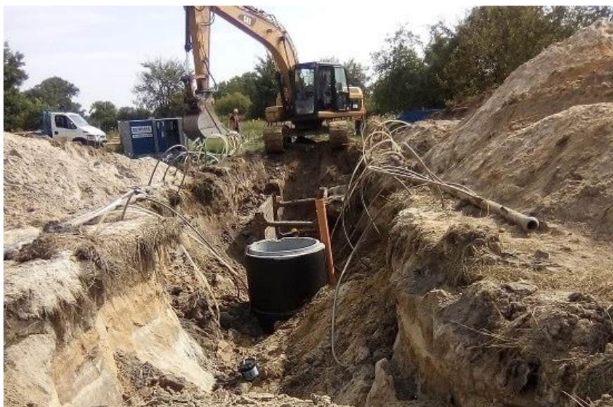
Budowa kanalizacji w m. Wola Baranowska
