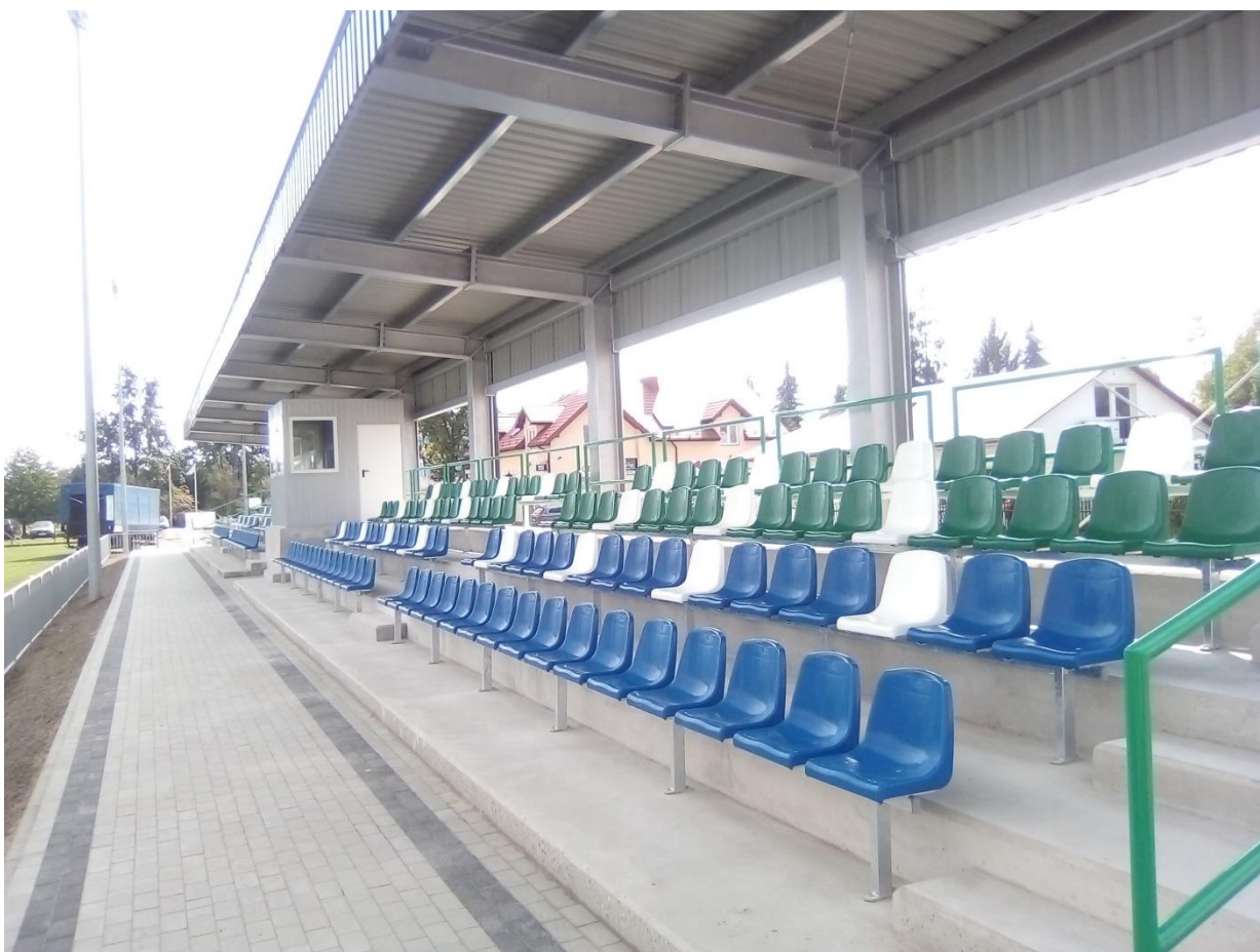
Zmodernizowana trybuna stadionu w Skopaniu
