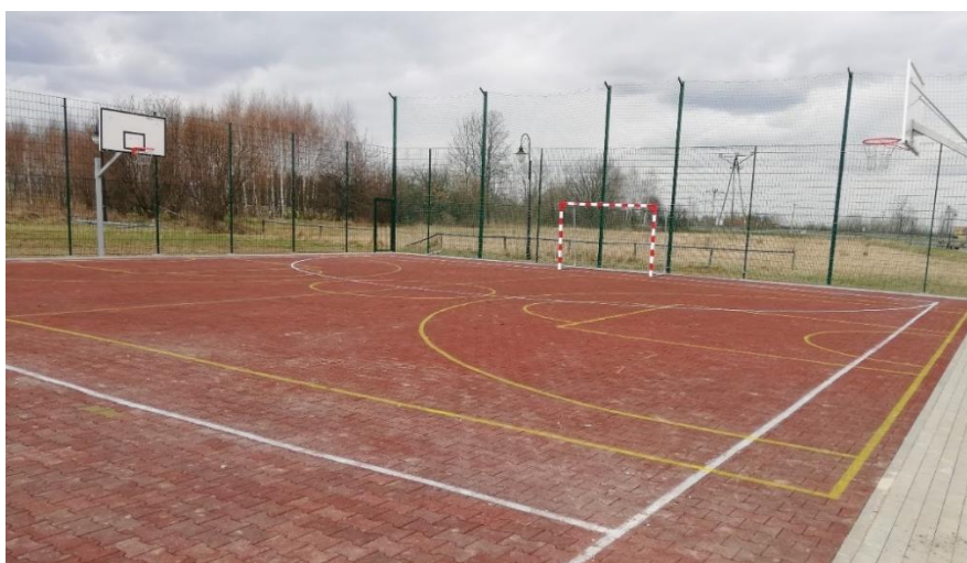
Boisko wielofunkcyjne w m. Suchorzów
