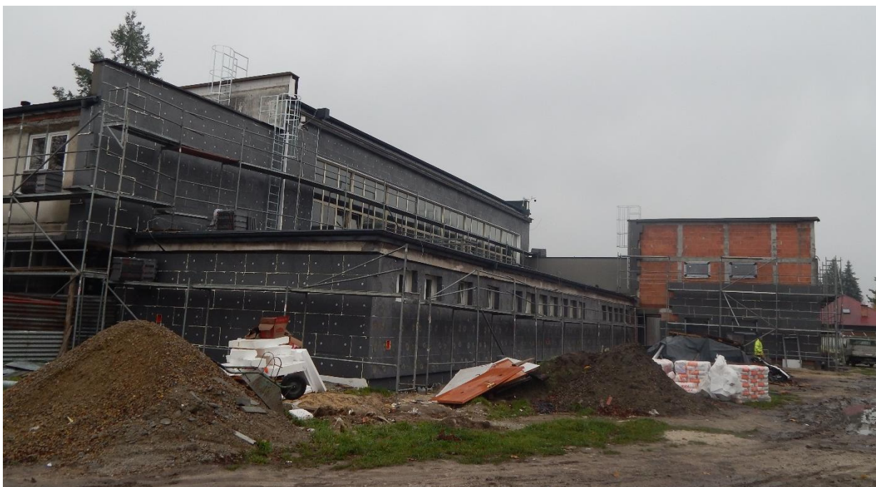
Przebudowa hali sportowej w Skopaniu (grudzień 2019)
