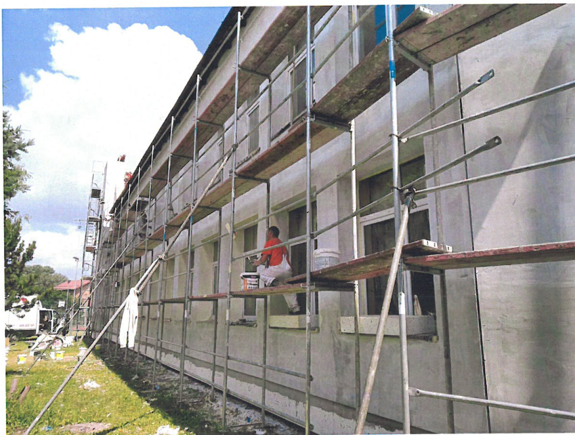
Termomodernizacja budynku szkoły w Baranowie Sandomierskim
