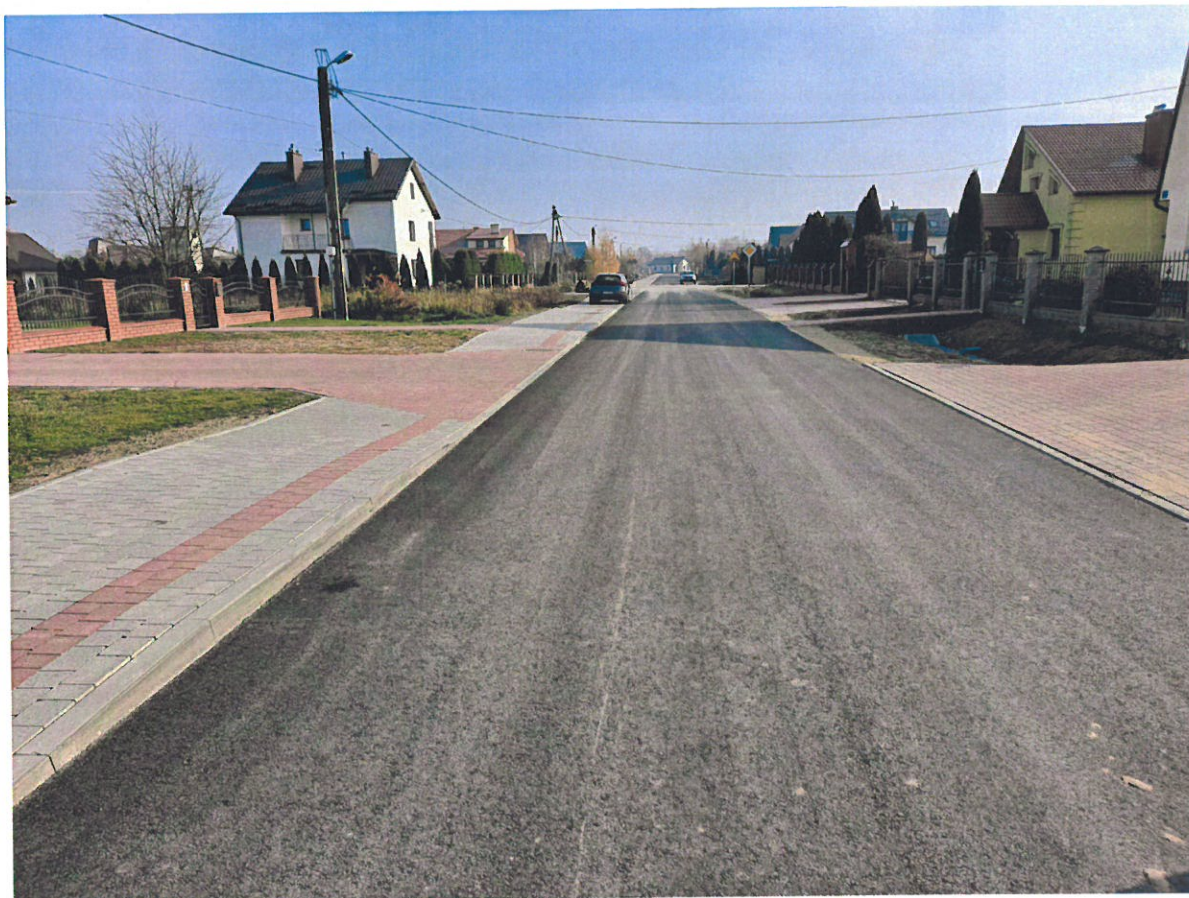
Budowa drogi na osiedlu piastowskim w Skopaniu
