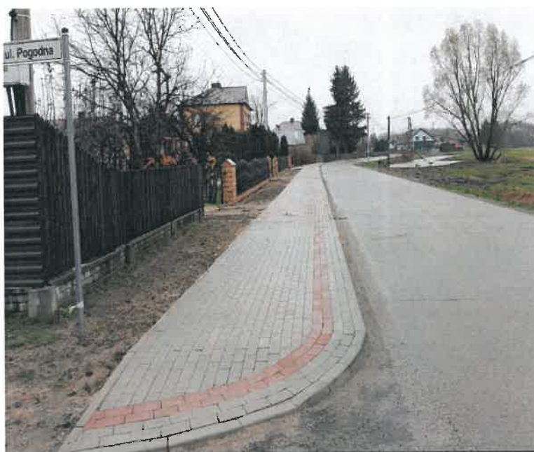
Budowa chodnika przy ul. Urszulin w Knapach
