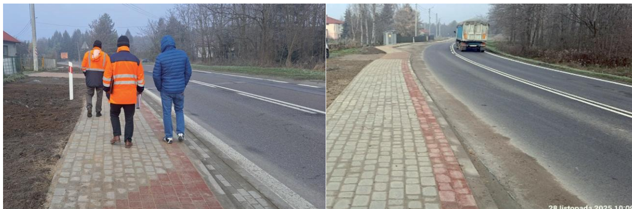
Przebudowa drogi wojewódzkiej nr 985 polegająca na budowie chodnika dla pieszych
