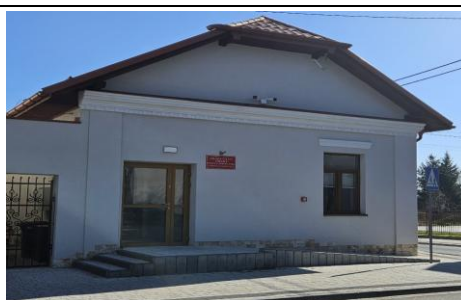
Poprawa efektywności energetycznej Baranów Sandomierski
