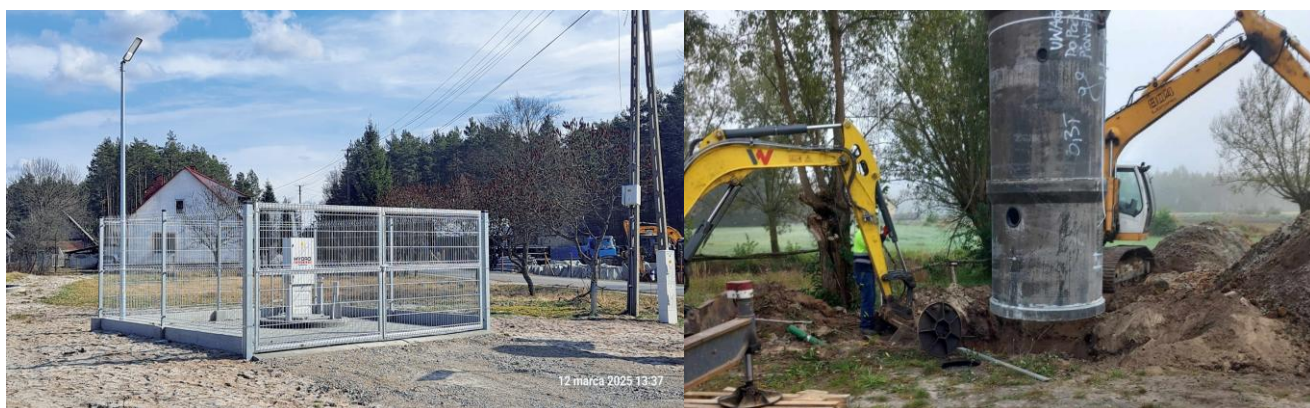
Rozbudowa sieci kanalizacji sanitarnej w miejscowości Kaczaki
